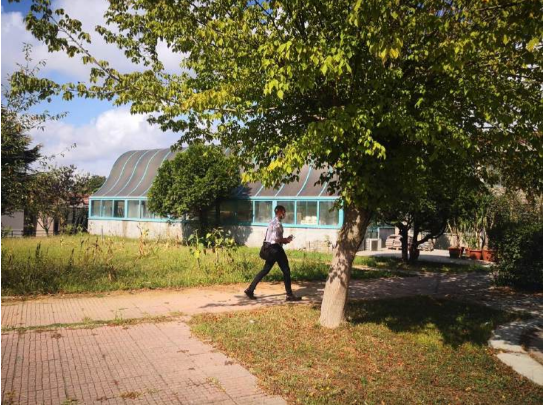
Şekil 8: Mimarlık ve Tasarım Araştırma Merkezine için tahsis edilen yapı (çatı sistemi değiştirilecektir)
