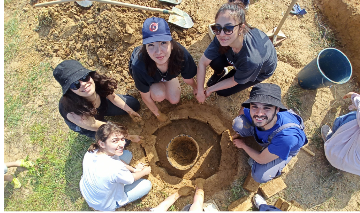
Kerpiç atölyesinde uygulama aşamalarından kareler.
